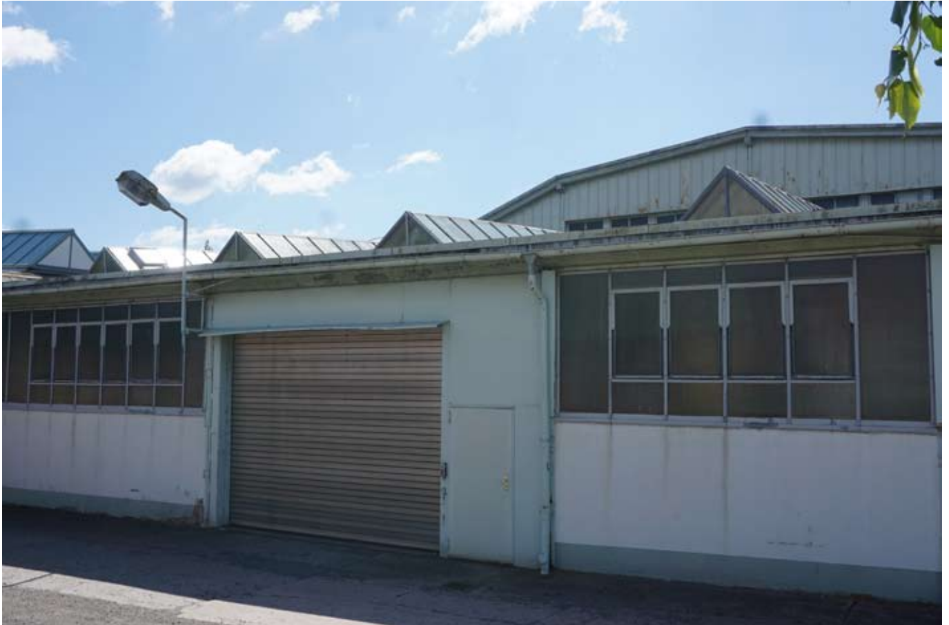
Ehemaliger Glasdachbau Zwickau, Grundlage ist ein Flugzeughangar aus dem 1. Weltkrieg in der Hetzer-Leimholzkonstruktion. Foto Petra Westphalen.
