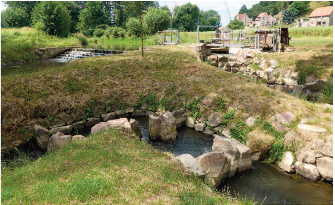
Stauwehr mit Fischtreppe am Ketzerbach in Schieritz
