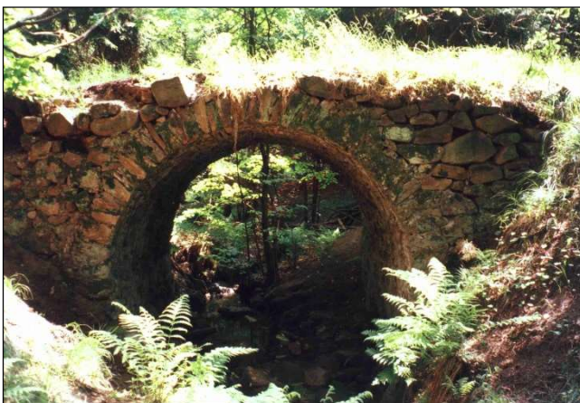
Die Hohe Brücke vor der 2003 erfolgten Sanierung
