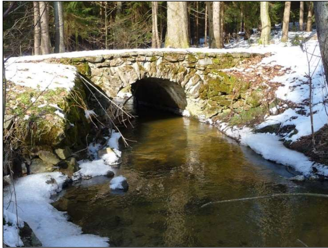
Gewölbter Prießnitzdurchlass im Zuge des Nachtflügels
