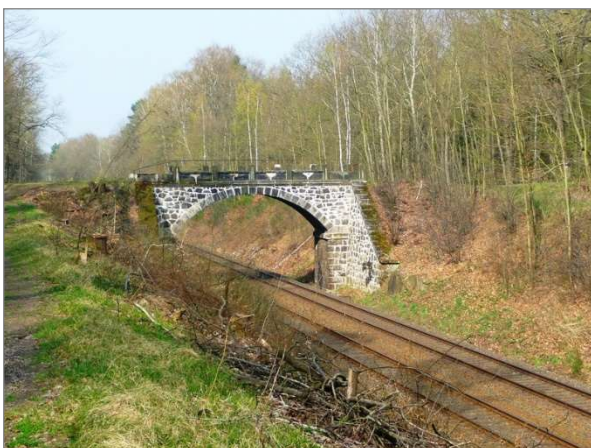
Die historische Bahnbrücke im Zuge des Unterringels nach Sanierung (2008)
