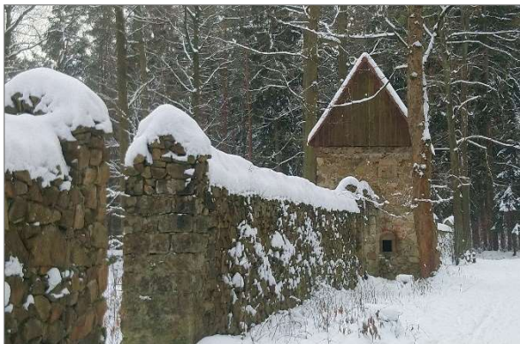
Wächterhaus im Langebrücker Saugarten
