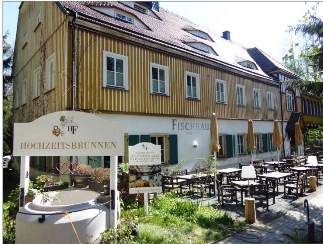
Das Fischhaus - früher Wohnung des Fischmeisters, später Forsthaus, bereits ab Mitte 17. Jh. Gaststätte © M. Thieme, 2020
