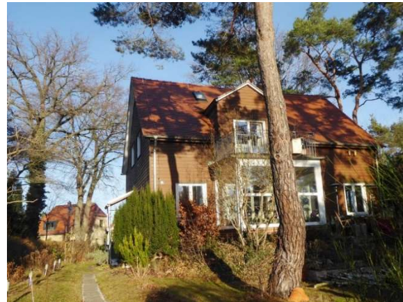
Am Sonnenhang: Wohnhäuser in naturnahem Umfeld
